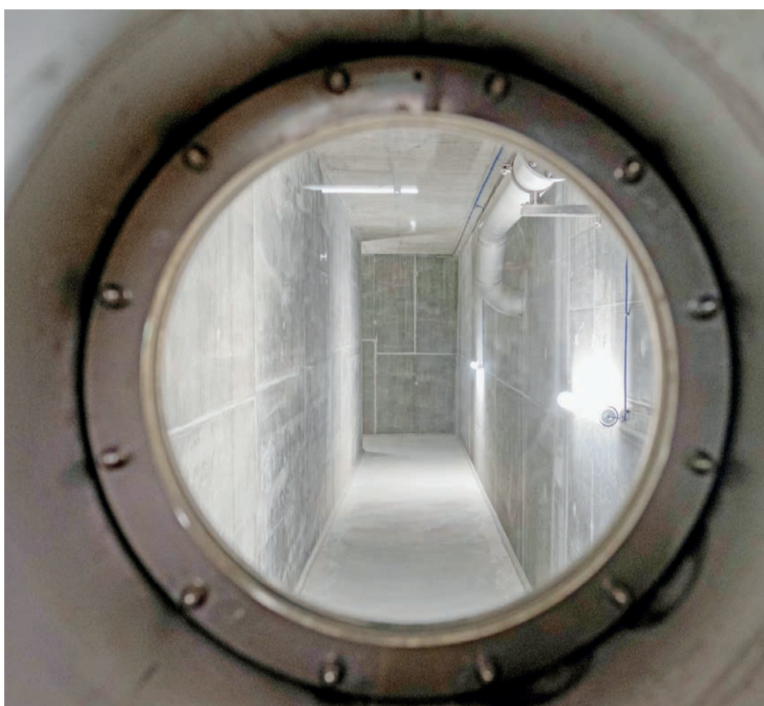
Das Seewasserwerk in Ipsach wird seit 2021 saniert. Das kostet 100 Millionen Franken.
